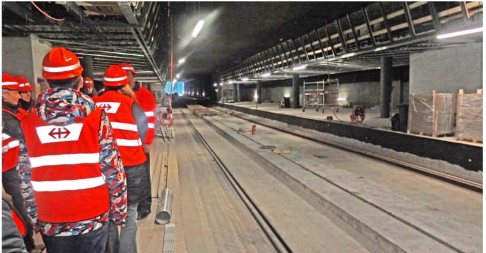
Auf der Baustelle des unterirdischen Bahnhofs Löwenstrasse
